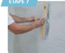
Si solution de doublage sur ossature, aplanir sur une hauteur de 20 cm à l'endroit précis où la fourrure sera posée. Se munir d'un couteau à enduire et d'un laser si possible.
