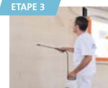
Dans le cas d'un support très absorbant (béton cellulaire), ou par temps très chaud, appliquer le primaire Lutèce® Régulateur de fonds. Pulvériser cette solution d'un geste régulier sur la surface complète du mur.
