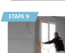
Nettoyage du chantier. Pose du doublage possible 48h après la projection.
