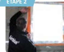
Protection des menuiseries extérieures. Utiliser un film plastique de protection « spécial menuiseries » (bande adhésive).
