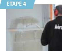
1<sup>re</sup> passe : projection de 3 mm d'épaisseur environ par pan de mur. Laisser 15 à 20 minutes avant la 2<sup>e</sup> passe.
