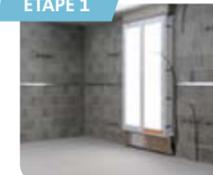
Nettoyage de la surface au sol. Bas de murs dépoussiérés sains et secs.
