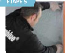
Traitement des points singuliers : noyer la bande de fibre de verre dans le revêtement technique intérieur aux jonctions menuiseries/maçonnerie et plafond/maçonnerie.
