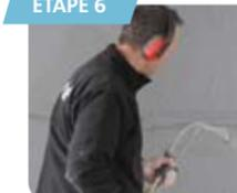
2<sup>e</sup> passe : projection de 2 mm environ sur chaque pan de mur (moins de 30 min après la 1<sup>re</sup> passe).
